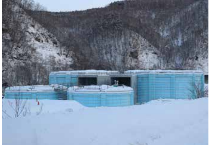
▲高岡地区に建設中のバイオガスプラント
